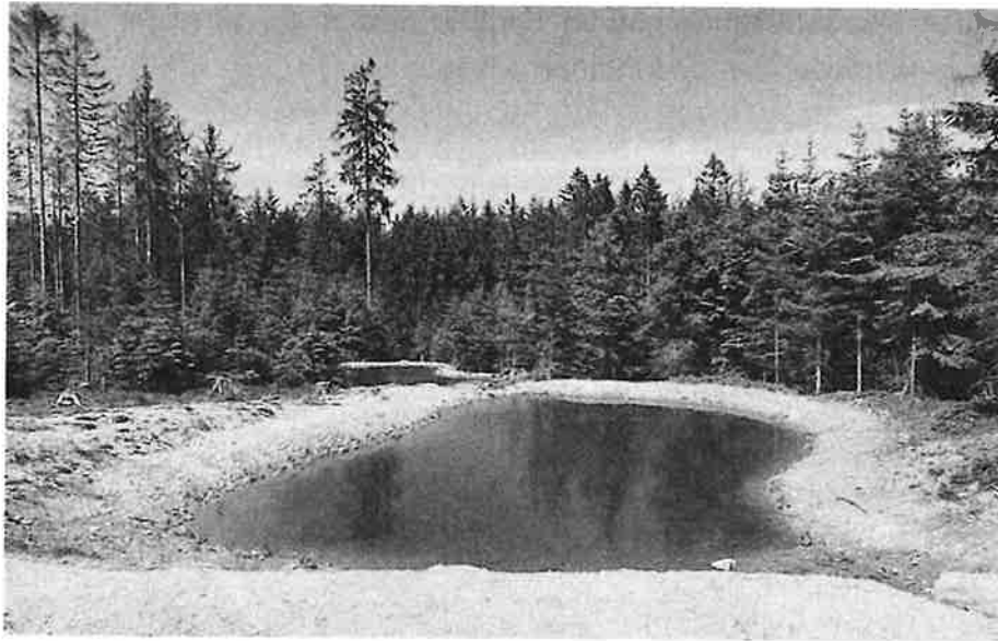
Abbildung 14: Wasserrückhaltebecken mit Tief- und Flachwasserzonen im Forstamt Wiesbaden-Chausseehaus (Quelle: J. Flikschuh, Hessen-Forst)
