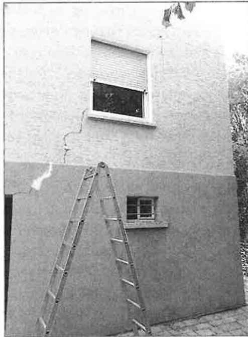
Abbildung 8: Typischer Risssschaden an einem Wohnhaus in Schöneck-Kilianstädten (Main-Kinzig-Kreis) während des Sommers 2015. Ursache für die Risse waren unterschiedlich große, geringfügige Setzungen des Baugrunds, als Folge von Schrumpfungen in tertiären Tonen (HLNUG)
